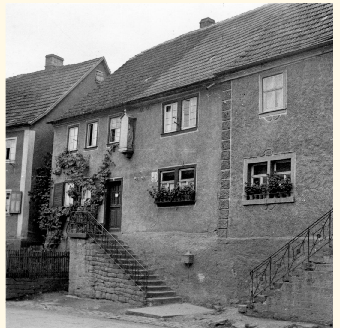
Ansicht des Wohnhauses
